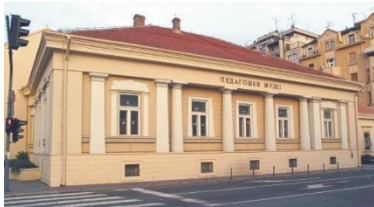
Sl. 65 Pročelje objekta
