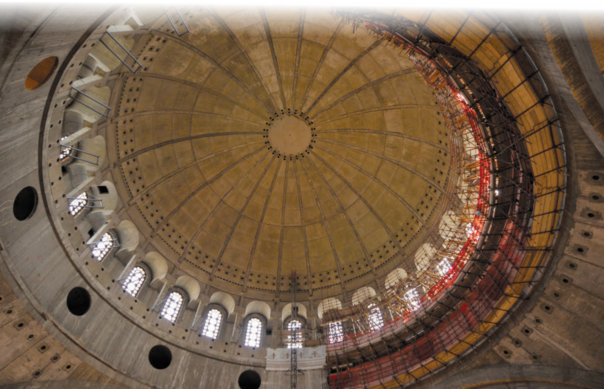
Поглед у куполу Храма, са конструкцијом поткуполне галерије и кружним отворима тамбура иза којих се протеже будућа галерија сталне изложбе о градњи Храма
