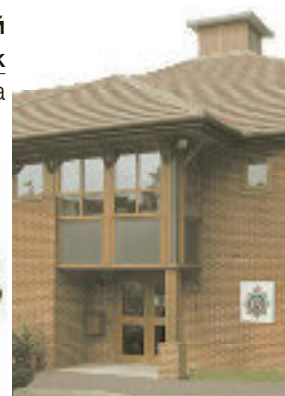
полицейский участок policijska stanica
