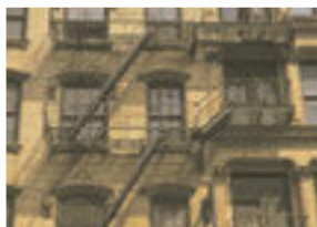
пожарная лестница požarne stepenice
