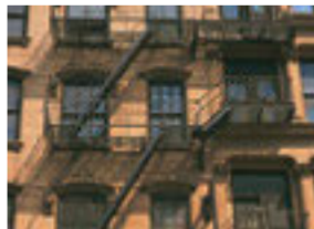
la scala di sicurezza požarne stepenice
